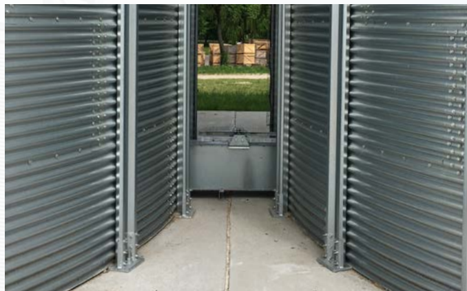
REDLER W KANALE WENTYLACYJNYM
