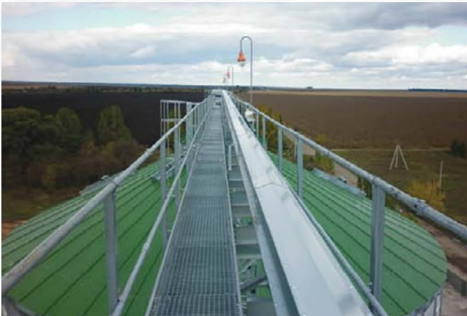
POMOST OBSŁUGOWY I URZĄDZENIE DO POZIOMEGO TRANSPORTU ZIARNA
